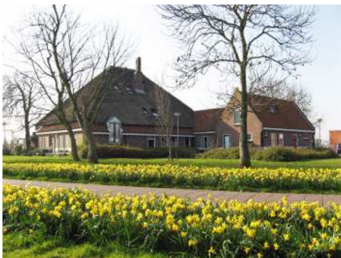
De bouwvallige Albert's Hoeve is in 1985 afgebroken en daarna op dezelfde plek in de oorspronkelijke vorm herbouwd (Molendijk 1 t/m 23). Foto: Ernst Mooij
